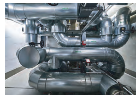
Die Energiezentrale (oben) mit Geothermie-Leitungen (Mitte) und Netzwerkpumpen (unten)
