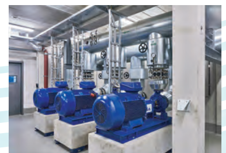
Die Energiezentrale (oben) mit Geothermie-Leitungen (Mitte) und Netzwerkpumpen (unten)
