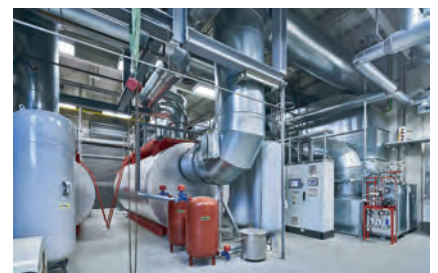
Sommer 2018 | Umbau und Erweiterung der Energiezentrale. Unter anderem erhält sie einen 15-MW-Gaskessel zur Absicherung der Wärmeversorgung.
