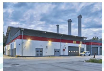
Ende 2021 | Rund 1.200 Objekte versorgt die moderne Energiezentrale auf dem ehemaligen Bohrgelände zuverlässig und rund um die Uhr, alleine in der vergangenen Heizperiode mit 47 Millionen Kilowattstunden Wärme.
